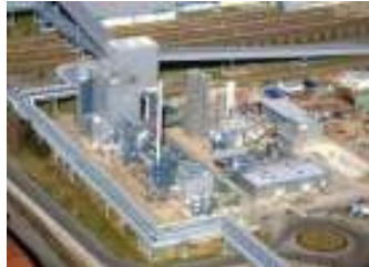
Vattenfall Schwarze Pumpe Germany - 30 MWth Oxy - Lignite
